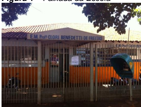
Figura 1 – Faixada da Escola
