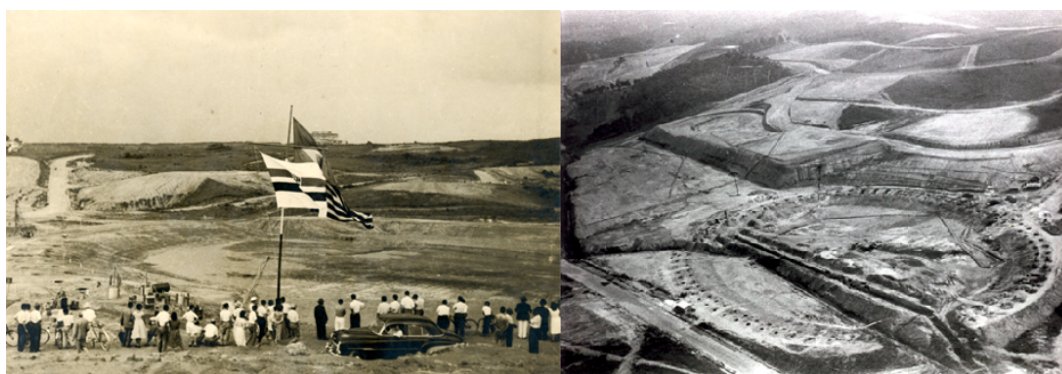
Figura 1 - Imagens do terreno destinado ao Estádio, nas primeiras etapas da construção
