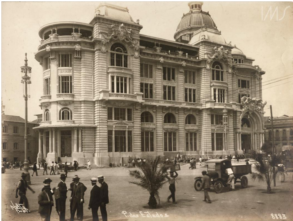
Figura 1 - Edifício do Ministério da Agricultura, projetado por Morales de Los Rios.
