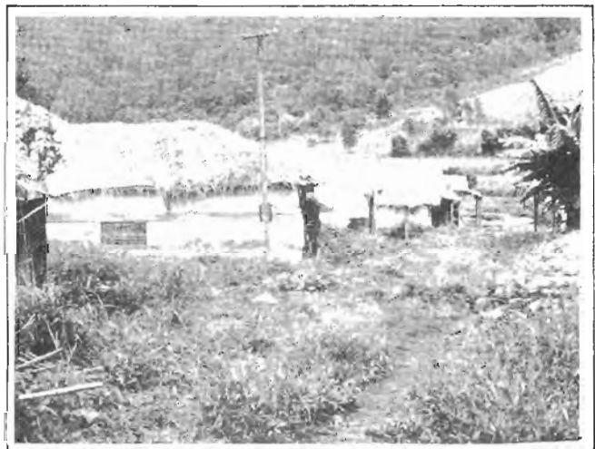
FIGURA 4: Casas de cultura em Mogi das Cruzes (SP), onde são revestidas por material refletor, cobertas com telhas e fina camada de sapé ( Imperata brasiliensis )
