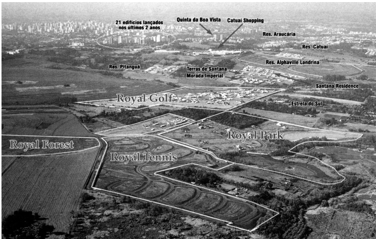
Figura 4. Vista aérea do entorno do Shopping Catuaí em 2002. Fonte: TEIXEIRA & HOLZMANN, out. 2003.
