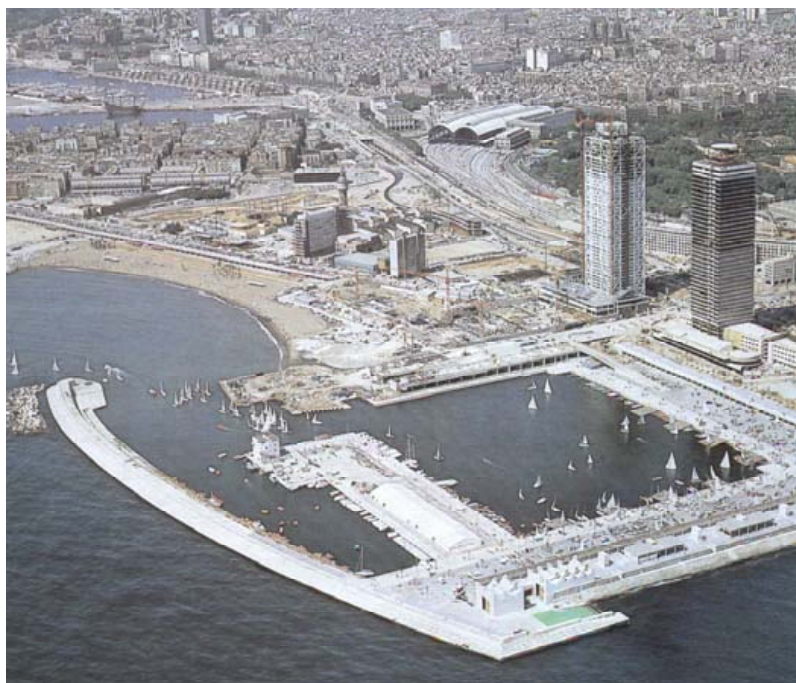
Figura 2. Vila Olímpica, Barcelona. Fonte: Villá, 1992, p. 75.
