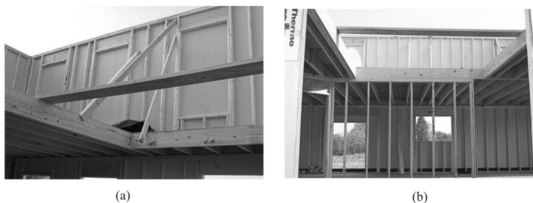
Figura 8. Contraventamento e detalhes da edificação. (a) Chapas de OSB externas; (b) Aberturas de portas e janelas.
