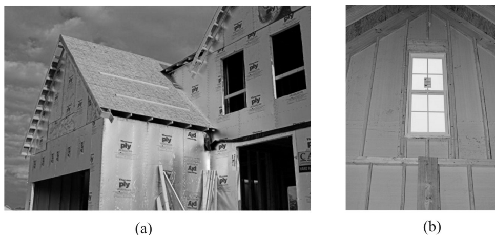
Figura 9. Cobertura: (a) Forro sobre treliças para colocação das telhas; (b) Vista inferior da estrutura de cobertura.
