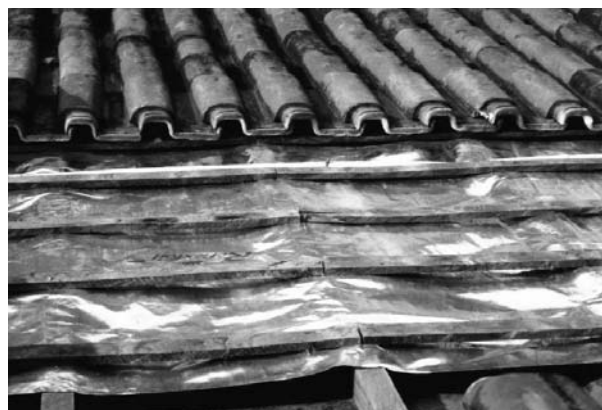
Figura 2. Colocação das lâminas sob as ripas e telhas
