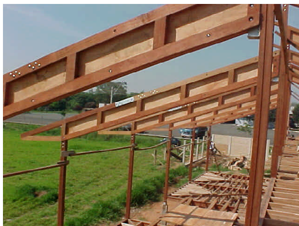
Figura 1 – Viga composta com alma em chapa de compensado utilizada em cobertura.
