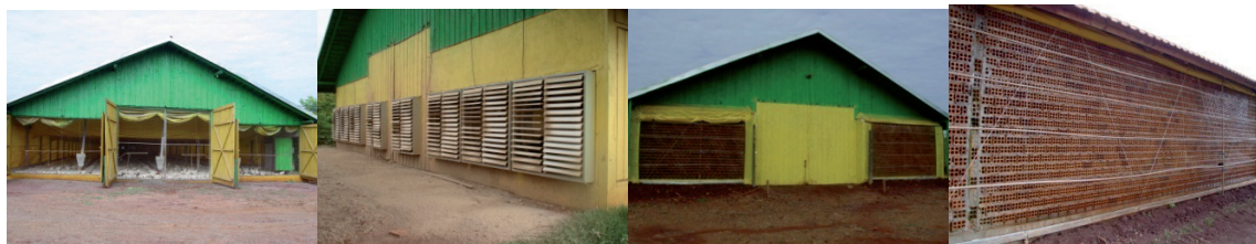
Figura 1. Vista frontal e posterior do galpão 1 (SRAE), vista frontal e lateral do galpão 2 (SRAE+SETV).
