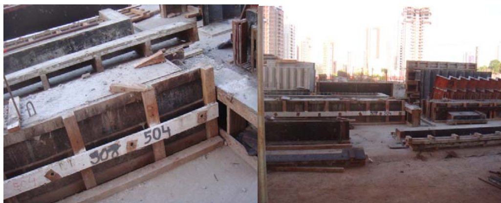
Figura 3- Formas das vigas de concreto rentes no chão
