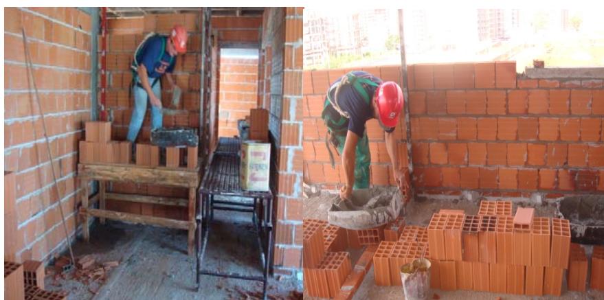
Figura 1- Pedreiro assentando tijolos-posturas inadequadas e movimentos repetitivos
