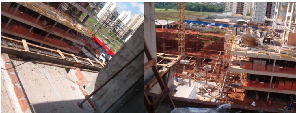
Figura 2- Cabo de aço fixado na viga lateral da parede externa
