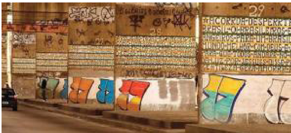
Figura 2 - Textos do poeta Gentileza, nas pilastras do Viaduto do Caju, depois da restauração. Rio de Janeiro, 2000.
