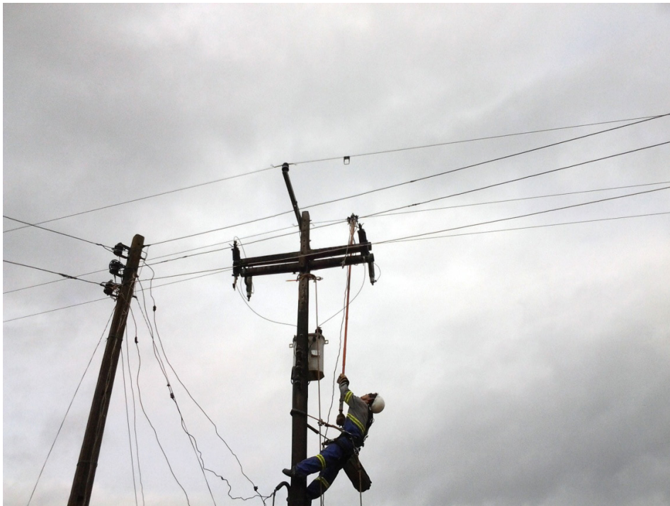
Figura 6 - Inclinação (para trás) da cabeça do electricista.
