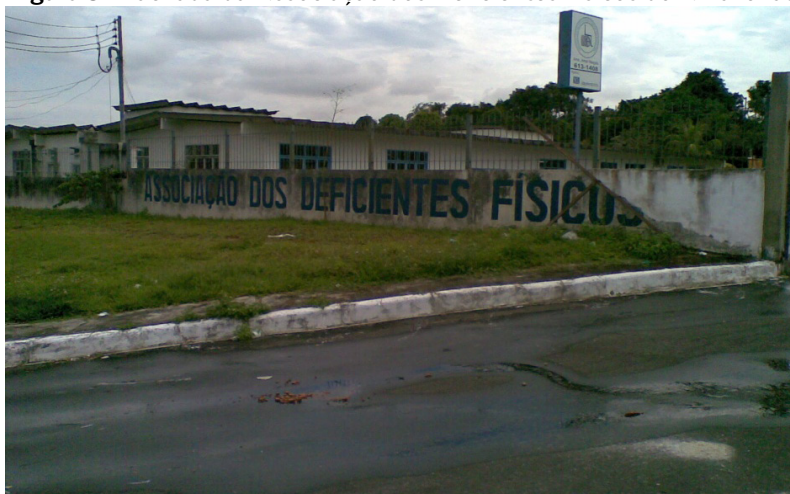
Figura 3 - Fachada da Associação dos Deficientes Físicos do Amazonas
