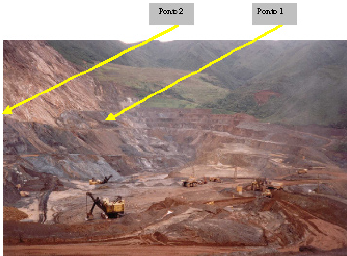
Figura 2 – Vista geral das operações de produção na Mina de Timbopeba e seu talude final.
