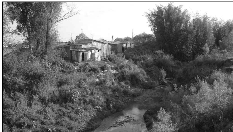
Figura 4 – Risco de erosão de margem e inundação na Vila Urlândia.
