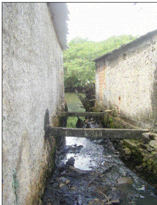
Figura 3 – Baixa infra-estrutura urbana em áreas de mangue.
