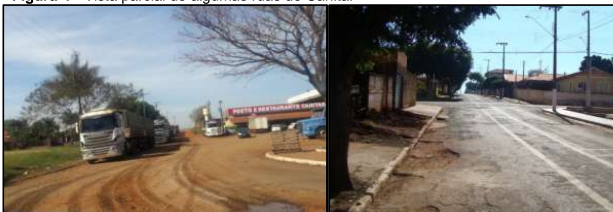
Figura 4 - Vista parcial de algumas ruas de Canitar
