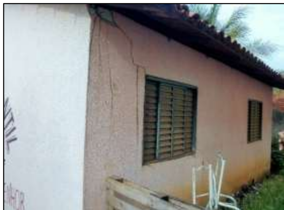
Figura 9 - Estrutura das moradias
