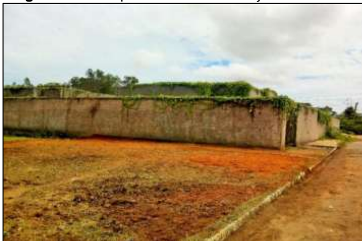
Figura 8 - Obra paralisada – construção de creche
