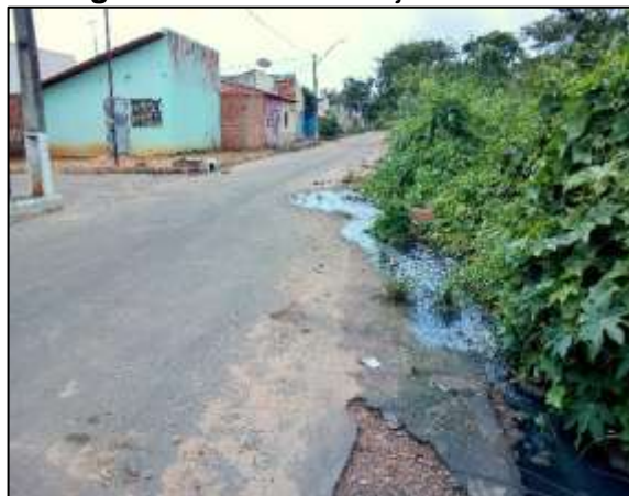
Figura 7 - Av. 2 no conjunto
