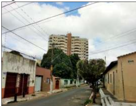
Figura 2 - Edifício 5ª Av./ bairro Bacuri
