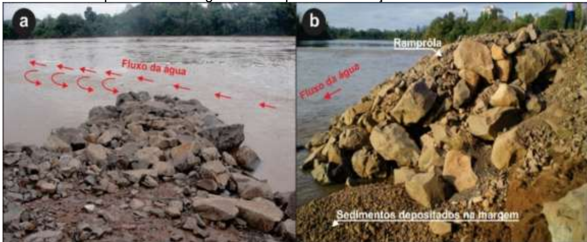
Figura 5 – a) efeito das ramprôlas durante elevação do nível de água do rio em um evento de inundação no ano de 2011, o fluxo é desviado para o centro do canal protegendo as margens a jusante; b) acúmulo de sedimentos ao longo da margem à jusante das ramprôlas, somente visível durante abertura das comportas da barragem eclusa para manutenção no ano de 2010
