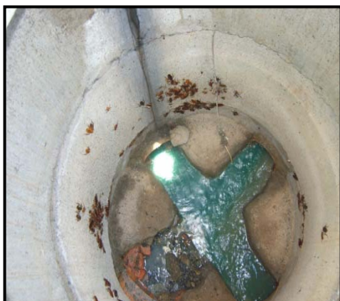
Figura 3 - Corante verde no poço de visita
