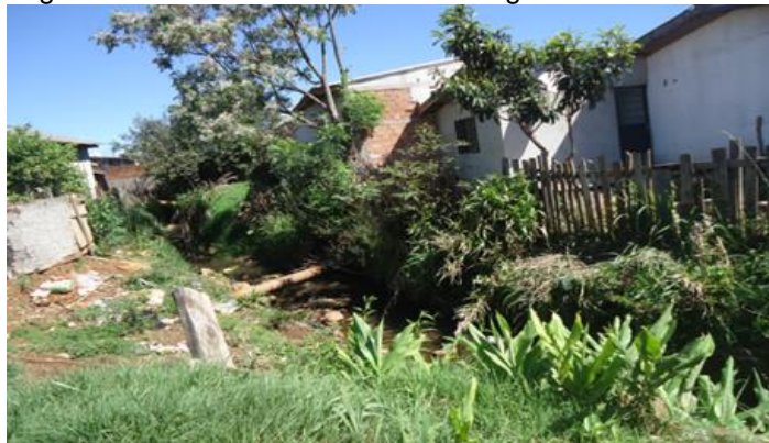
Figura 04. Ausência de sistema de esgotamento sanitário.
