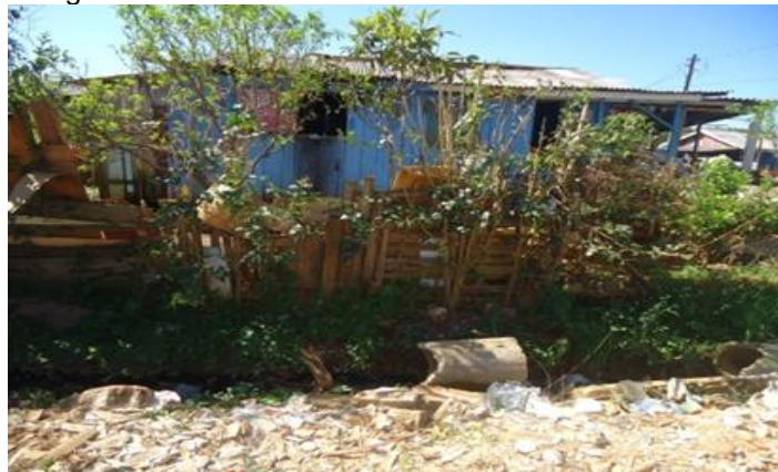
Figura 03. Precária infraestrutura habitacional.
