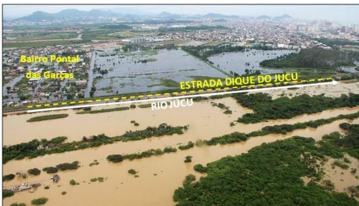
Figura 9. Alagamentos em bairros próximos ao Jucu e inundações do canal principal em dezembro de 2013.
