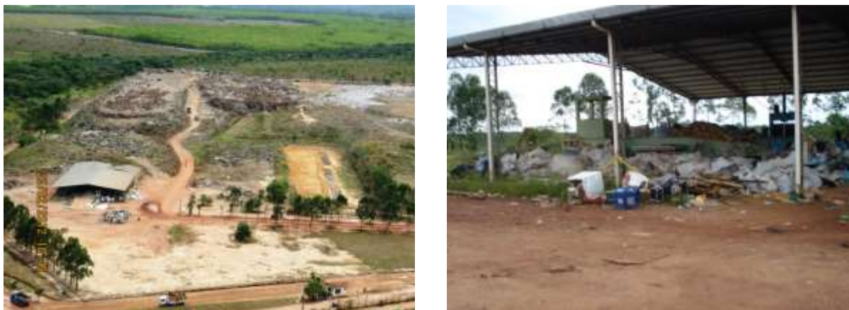
Figura 2 - Galpão onde opera a cooperativa UNIRENDA, dentro do Aterro Sanitário da PMBV
