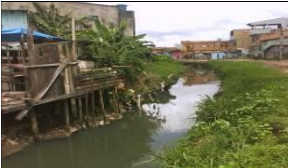
Figura 7- Trecho não retificado e com ocupações residenciais na planície de inundação do canal da Três de Maio.
