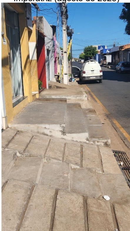
Figura 6 – Exemplo de ausência de padrão na construção de calçadas na cidade de Imperatriz (agosto de 2025)
