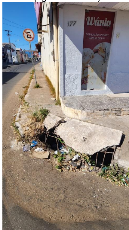
Figura 5 – Exemplo de situação de calçada em estado crítico na cidade de Imperatriz (agosto de 2025)
