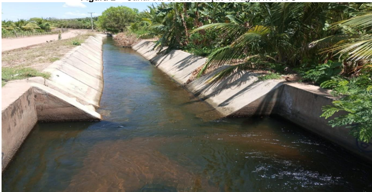
Figura 2 – Canal sul de distribuição de água no PISG
