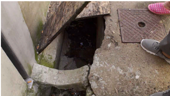
Figura 9 – Um dos acessos aos esgotos da primeira rua. Still do vídeo participativo. Maio de 2019.
