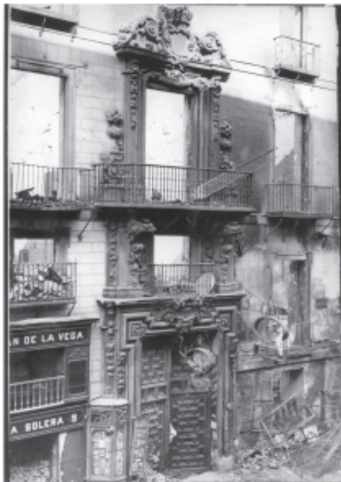
Figura 2 - Estudio de Fotos Galán derruido
