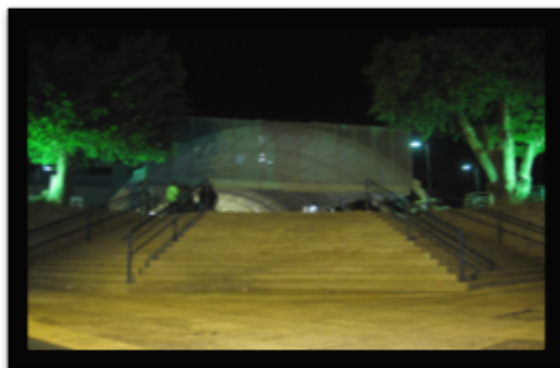
Figura 4: Fotografia da escada de acesso ao Centro de Convivência
