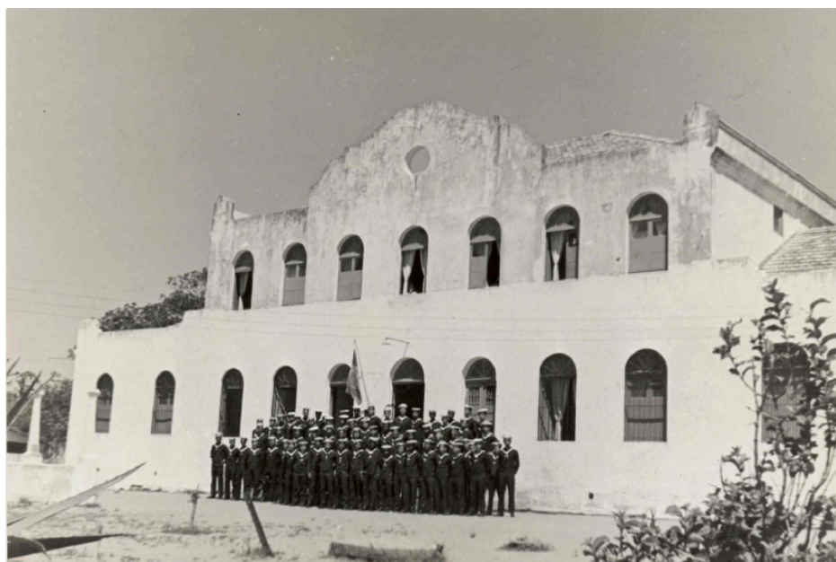
Figura 1 - Fachada da Escola de Aprendizes Marinheiros de Santa Catarina
