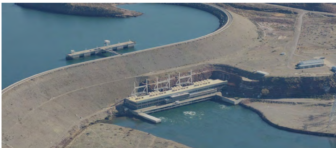
Imagen 3 - Dique y central hidroeléctrica El Chocón
