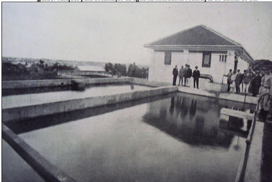
Figura 3: Tanques para decantação da água na Hidráulica Municipal de Caxias do Sul
