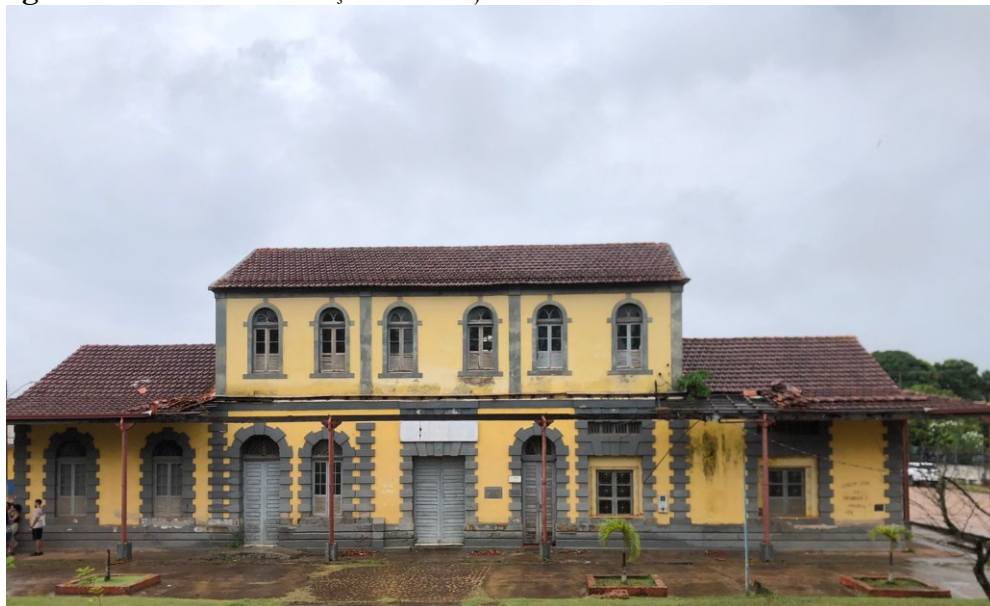
Figura 1 - Fachada da Estação de Guajará Mirim fechada e estado de abandono
