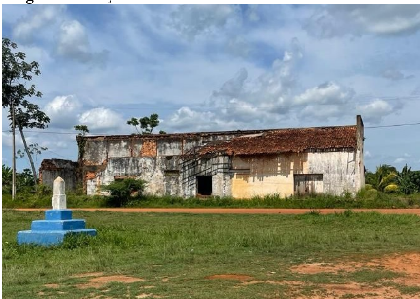
Figura 3 - Estação Ferroviária desativada em Vila Murtinho
