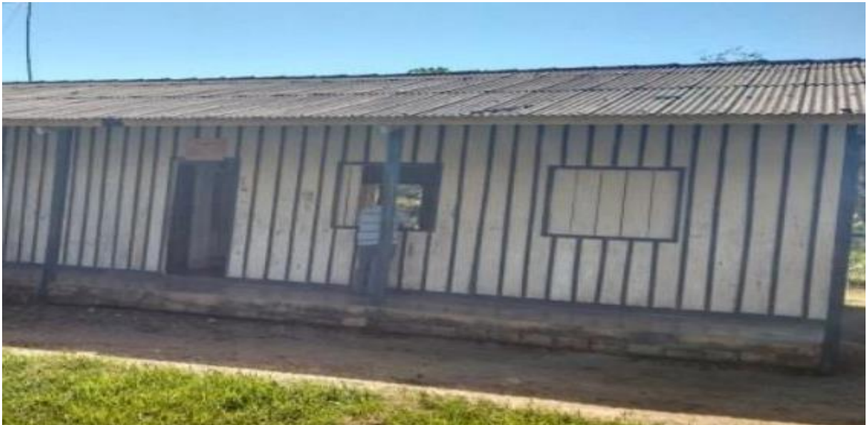
Figura 02 – Prédio da Escola Indígena
