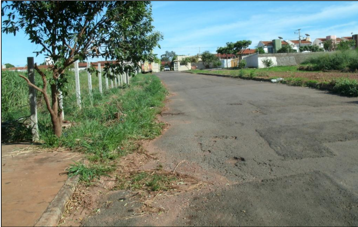
Figura 08 - Vista lateral da nascente do Vassoral, ao fundo condomínio horizontal sobre um olho d'água (área de APP).
