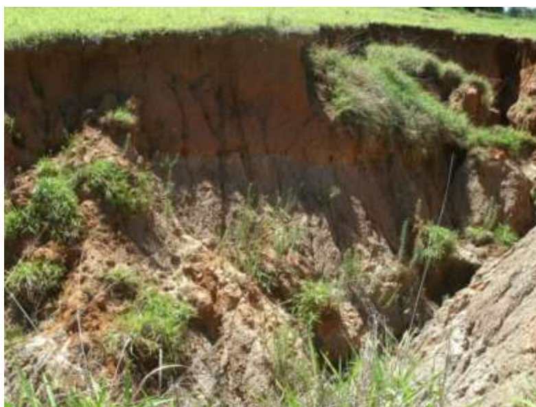
Figura 3 - Voçoroca na área da visitação de campo da microbacia do Cedro.
