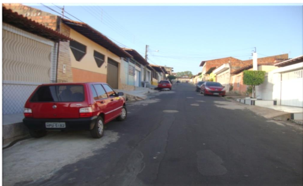
Figura 2 - Conjunto Habitacional Bairro Angelim em São Luis - MA
